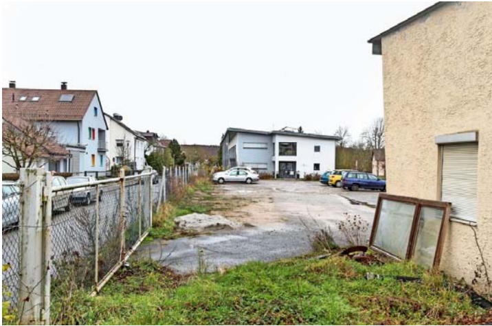
Auf der Brachfläche neben der Krippe Rankbachstraße entsteht der Neubau. Foto: factum/Bach
