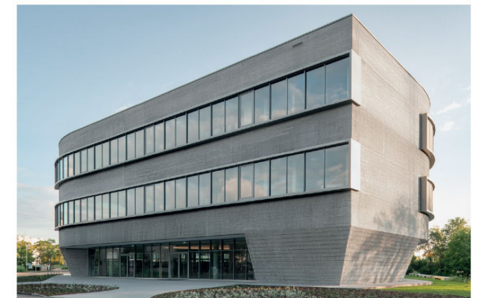
94 Verwaltungsgebäude Gustav Eppler Bauunternehmung, Stuttgart Beitrag: a+r ARCHITEKTEN GmbH
